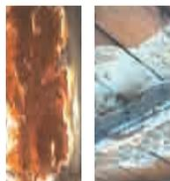
A presença de **altos índices de umidade** promove a formação deste fungo Xilófago na madeira. Seus **filamentos microscópicos** propagam-se no interior da madeira causando danos irreparáveis.
